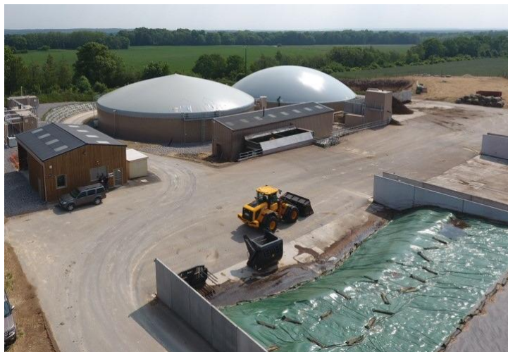
L'unité de méthanisation Mahé Bioénergie, à Boutigny (Source : GRDF)
