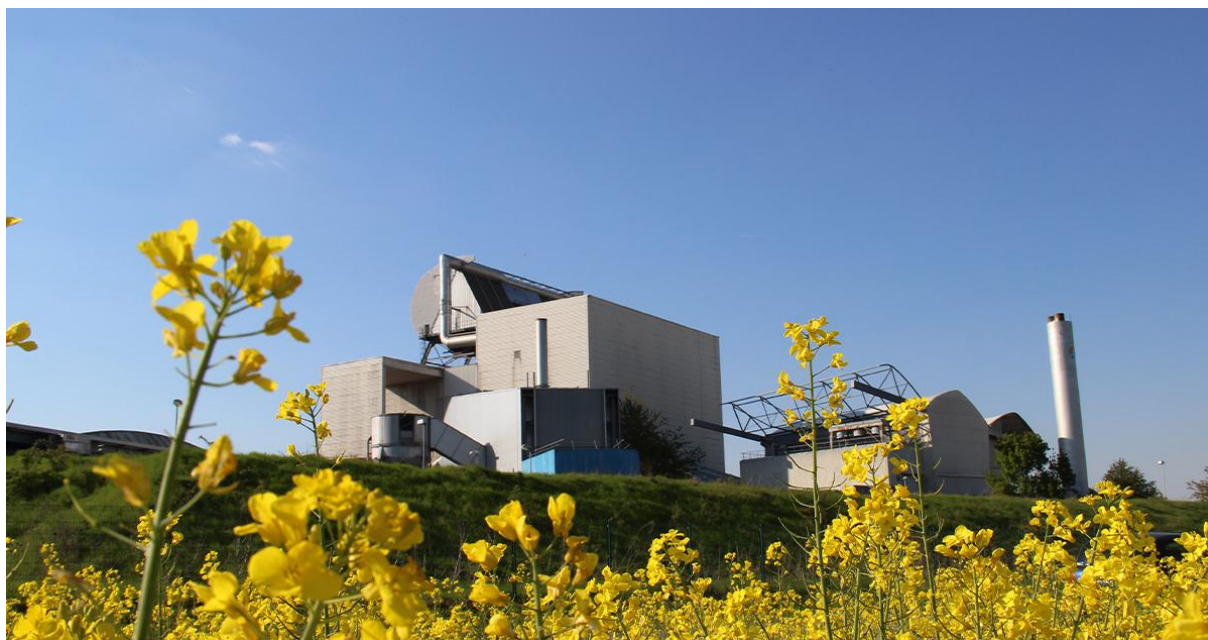
Usine d'Incinération des Ordures Ménagères (UIOM) de Monthyon- Source : SMITOM
